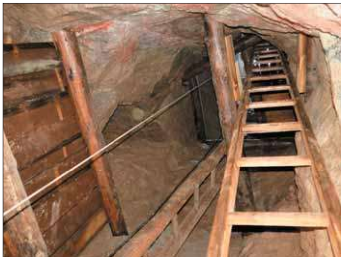
Obr. 11 Stvol staré šachty po vyzmáhání a vystrojení v duchu 16. století, KŠ2 Fig. 11 Old shaft after remediation and equipment restoration by the methods of the 16 th century, KŠ2
